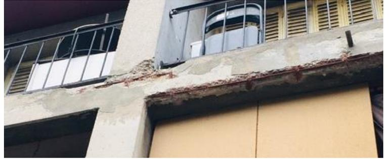
L'éclatement du béton découvre les armatures en acier sur un grande surface et profondément dans la matière.
